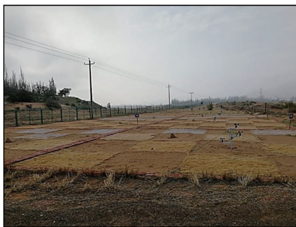
图3 生态垫固沙
